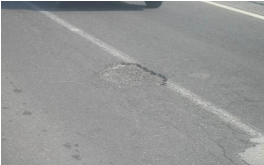
SLIKA 15. MANJA RUPA NA KOLNIKU (MALI STUPANJ)
