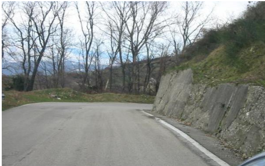
SLIKA 9. NEDOSTATAK PLOČA ZA OZNAČAVANJE OŠTROG ZAVOJA (VISOKI STUPANJ)
