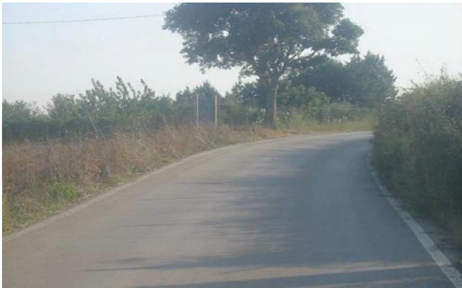
SLIKA 13. IZBLIJEĐENE RUBNE CRTE KOLNIKA (MALI STUPANJ)
