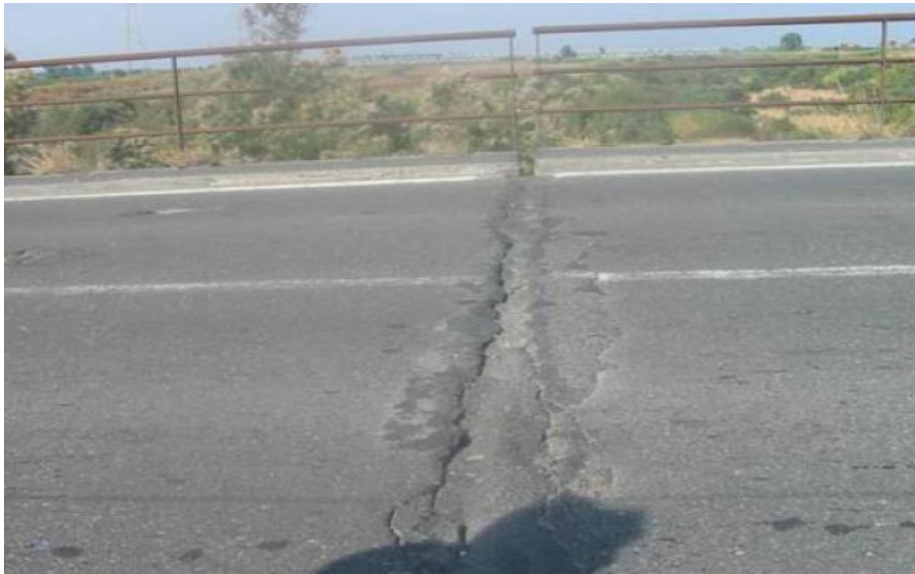
SLIKA 14. OŠTEĆENI SPOJ NA MOSTU (VISOK STUPANJ)
