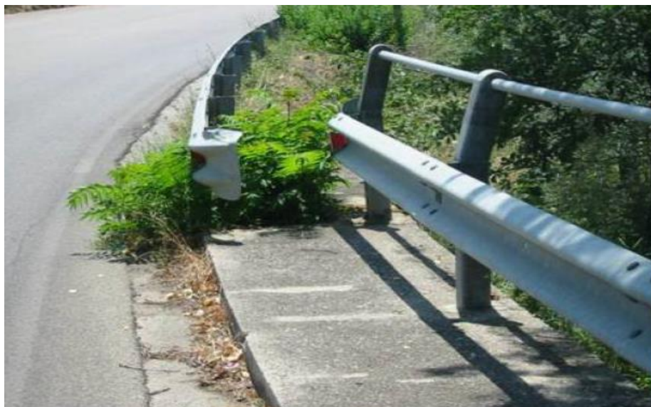
SLIKA 16. NEUSKLAĐENOST ZAŠTITNE OGRADA UZ KOLNIK I NA MOSTU - BEZ SPOJA (VISOKI STUPANJ)
