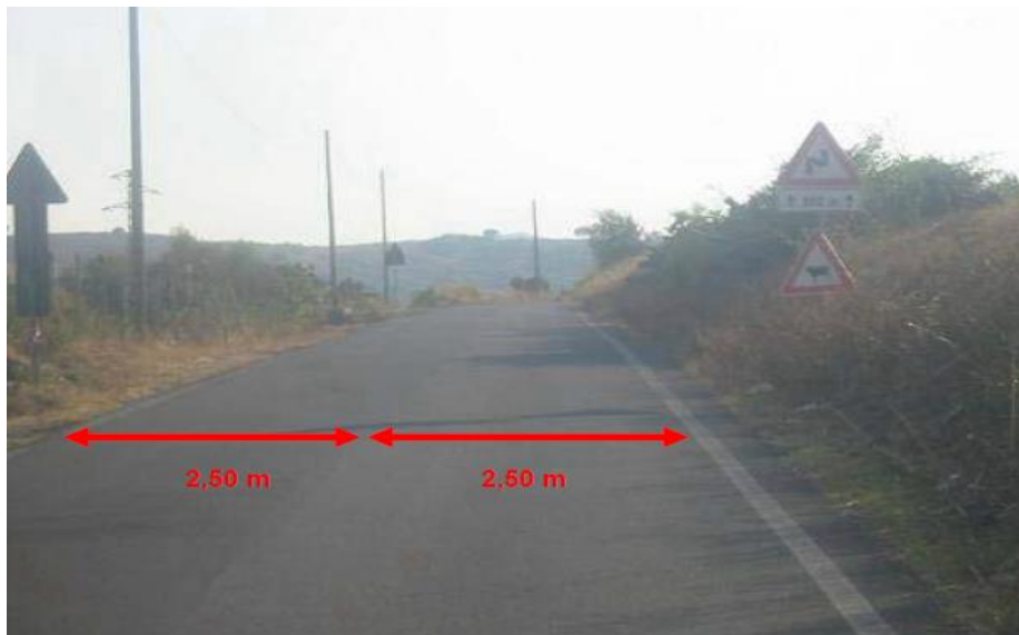
SLIKA 11. ŠIRINA PROMETNE TRAKE NA DRŽAVNIM CESTAMA MANJA OD 2.75 M (VISOKI STUPANJ)
